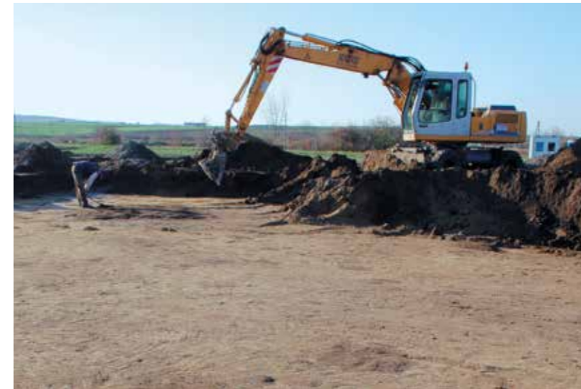
Baggerarbeiten (Oberbodenabtrag) in Aspersdorf, Bezirk Hollabrunn (Foto: Maria Linke, ARDIG)
