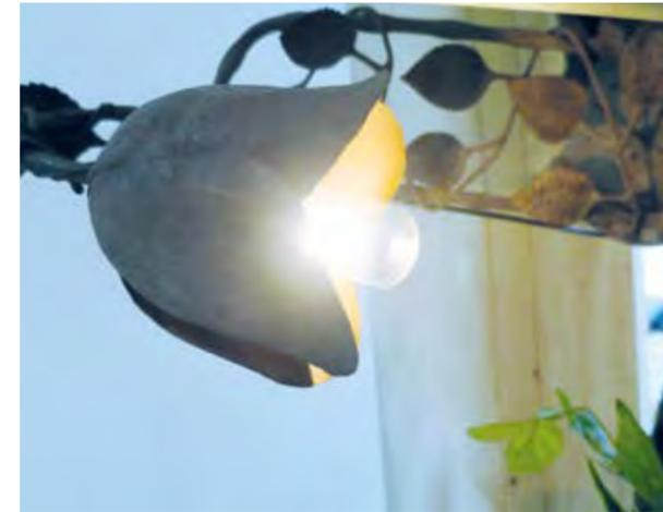
Bild links: Vergebauete Ersatzlampe durch eine in Größe und Form entsprechende Halogenlampe mit Bajonettsockel.
